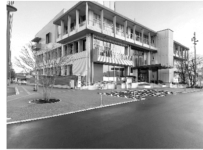
駐車場やスロープが改修された市役所本館
