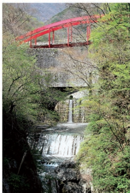
下流から見た芦安堰堤と瀬戸大橋
