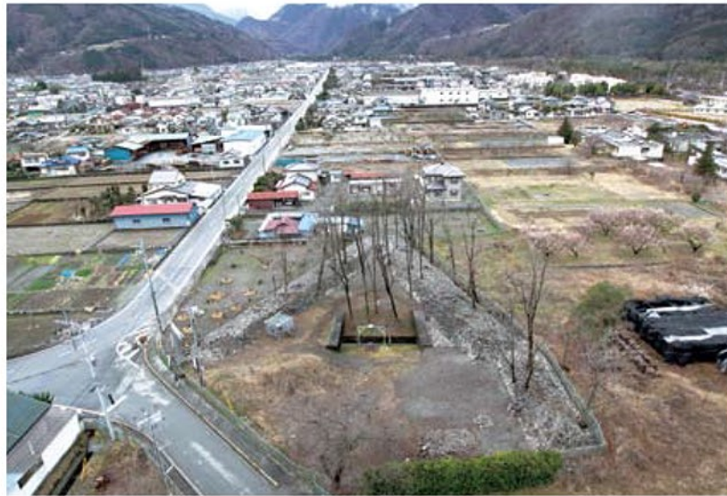
柵形堤防内に見えるのが徳島堰から後田堰へ取水するための取水口で、暗渠から一度開口している様子がよくわかる。(県立わかば養護学校付近上空から西方向を写している)
