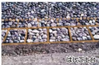
一列は石積みを支える土台として、1列は根固めに応用して利用されています。
