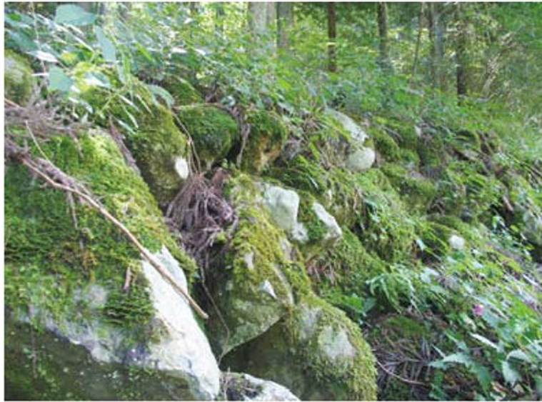
現在も砂防工事の石積み護岸が見られる市之瀬川
