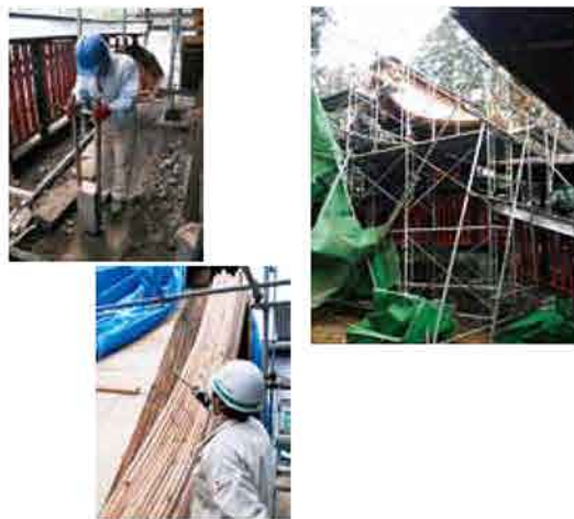
修復工事の様子
