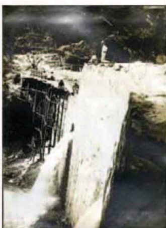
芦安堰堤アーチ式工事写真 日本で初めてコンクリートを使用して造られた本格的な砂防堰堤。日本砂防史の転機となった。
