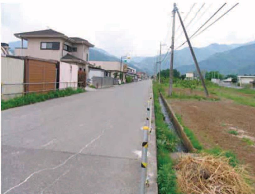
石縦堤（有野） 現在は堤防の役割を終え、道路として利用されている。
