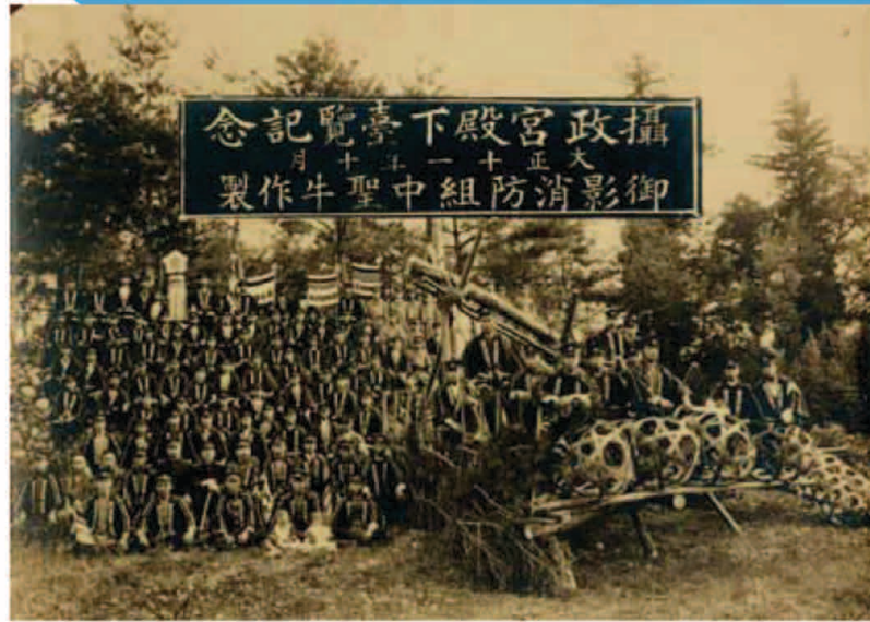
大正11年10月御影村（六科・野牛島・上高砂）消防団によって作られた中聖牛。竹蛇籠が利用されている。
