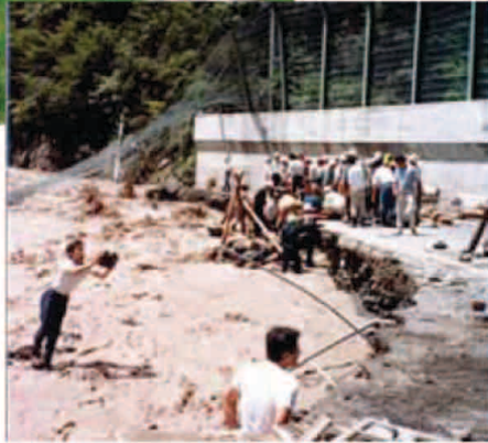
昭和57年芦安地区で起きた洪水の際、決壊した場所を保護するため、地元の人々が協力して作った牛を設置している
