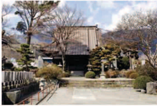
了円寺の七面堂 山門を入れて真正面に建てられている
