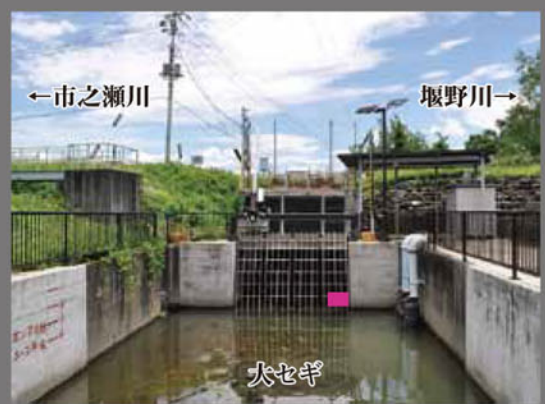
現在の井路縁川樋門 落合地区の水を集めた大セギは、ここから市之瀬川、堰野川の下に潜り、坪川南側に出て坪川と合流する。川を越えてから、坪川と合流するまでの部分が井路縁川。写真中の■は、史料から明らかとなる天保4年(1834)頃の樋門の大きさ。現在よりもずいぶん小さかったことがわかる。
