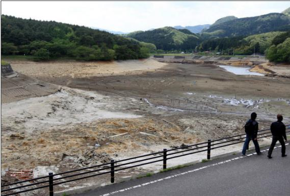
地震で堤防が決壊し、貯水が流れ出て干上がった藤沼湖。
