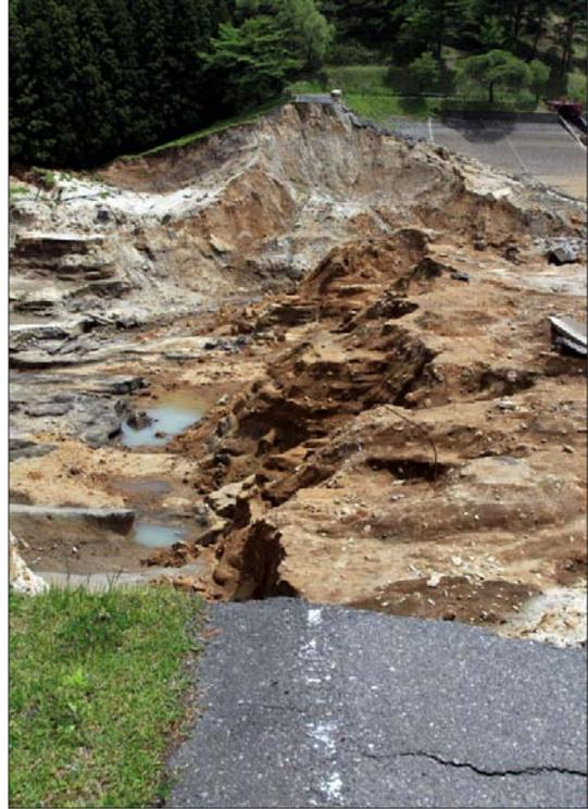
堤防が決壊した現場。震度6弱近い揺れで堤防に亀裂が入り約150万トンの貯水が一気に流れ出した。
