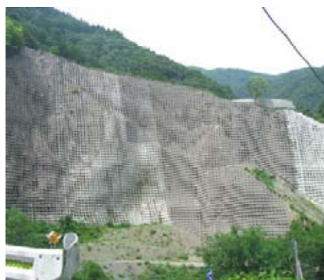
・南アルプス林道沿いの巨大な法枠
