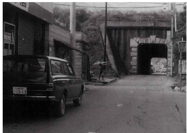
・かつて天井川の下につくられた市之瀬川隧道
