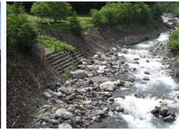
・蛇籠による護岸整備(広河原)
