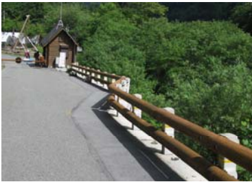
・南アルプス林道のガードレール
