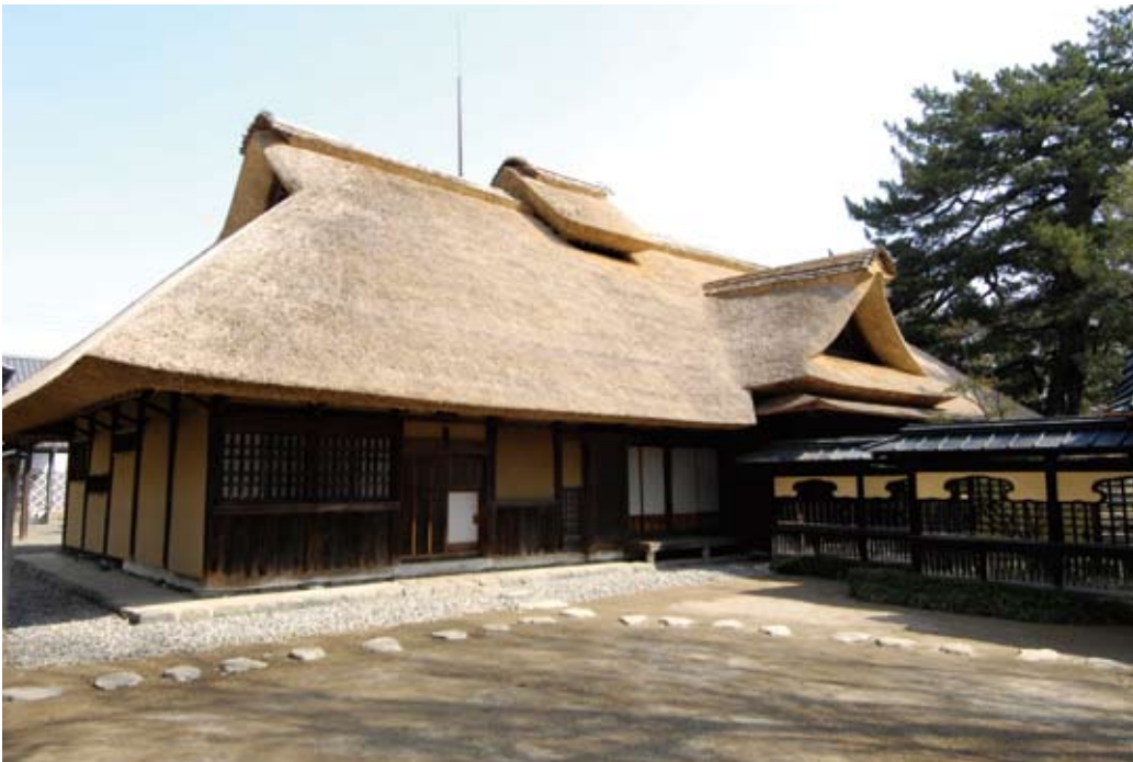
葺き替え後の安藤家住宅
