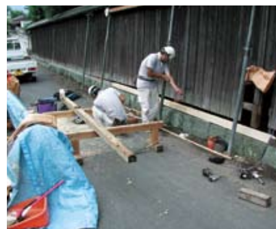
板塀の修復風景
