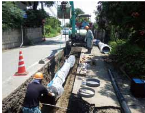
耐震管の布設工事の様子 昭和31年以降徐々に構築されてきたことから、老朽化が進行しています。
