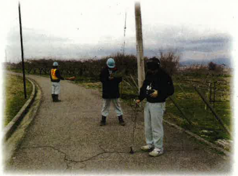
音聴調査による漏水箇所の特定
