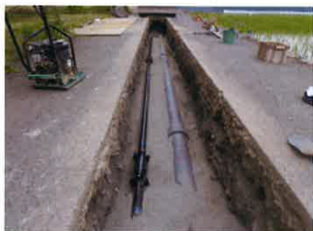
耐震管と耐震適合管の布設状況
