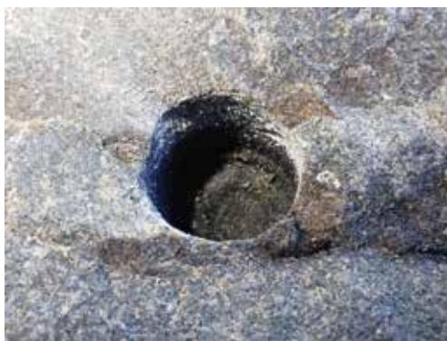
写真8 電動工具であけた孔の様子
