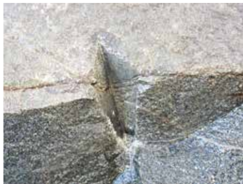
写真6 人力であけた孔の様子
