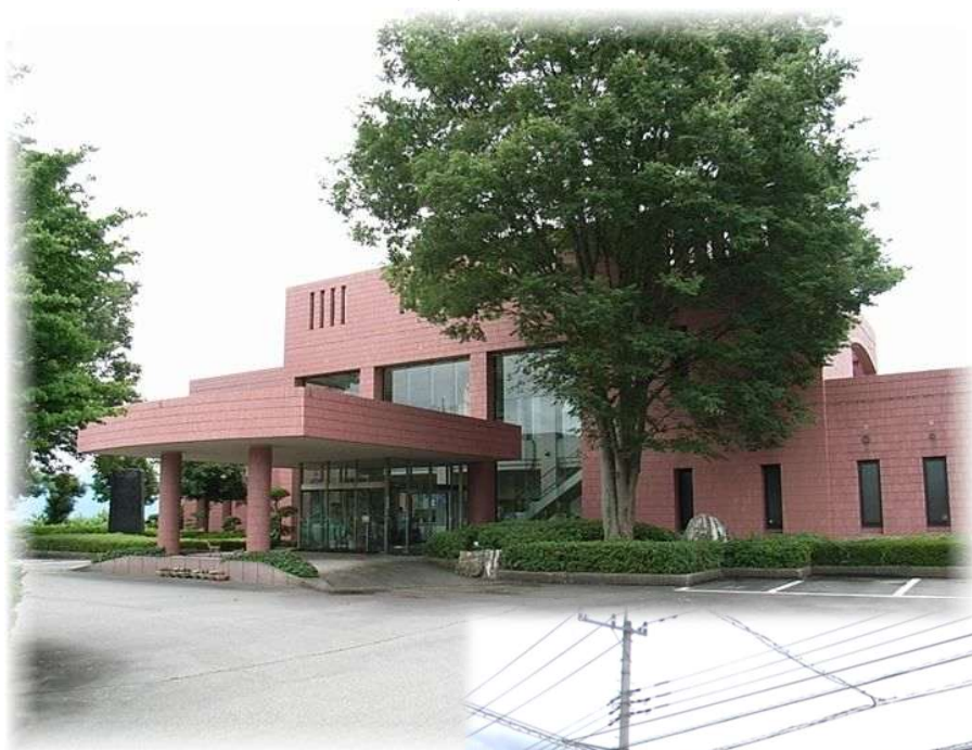
南アルプス市上下水道局庁舎
