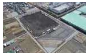
工事後の甲西市民総合グラウンド
