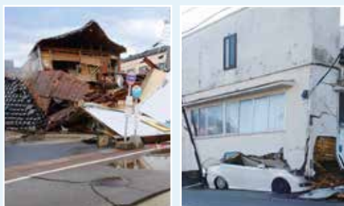
被災後の穴水町の様子。家屋が倒壊し道路の亀裂も確認できる
