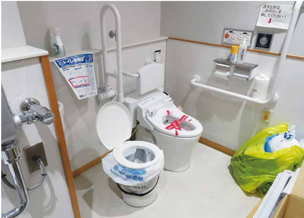
能登半島地震の際に、断水で水洗トイレが使えず、簡易トイレが設置された様子(石川県珠洲市健民体育館)
