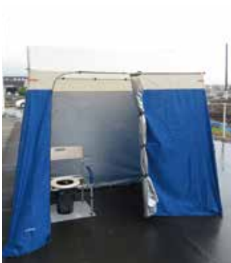
車椅子に対応したマンホールトイレ
