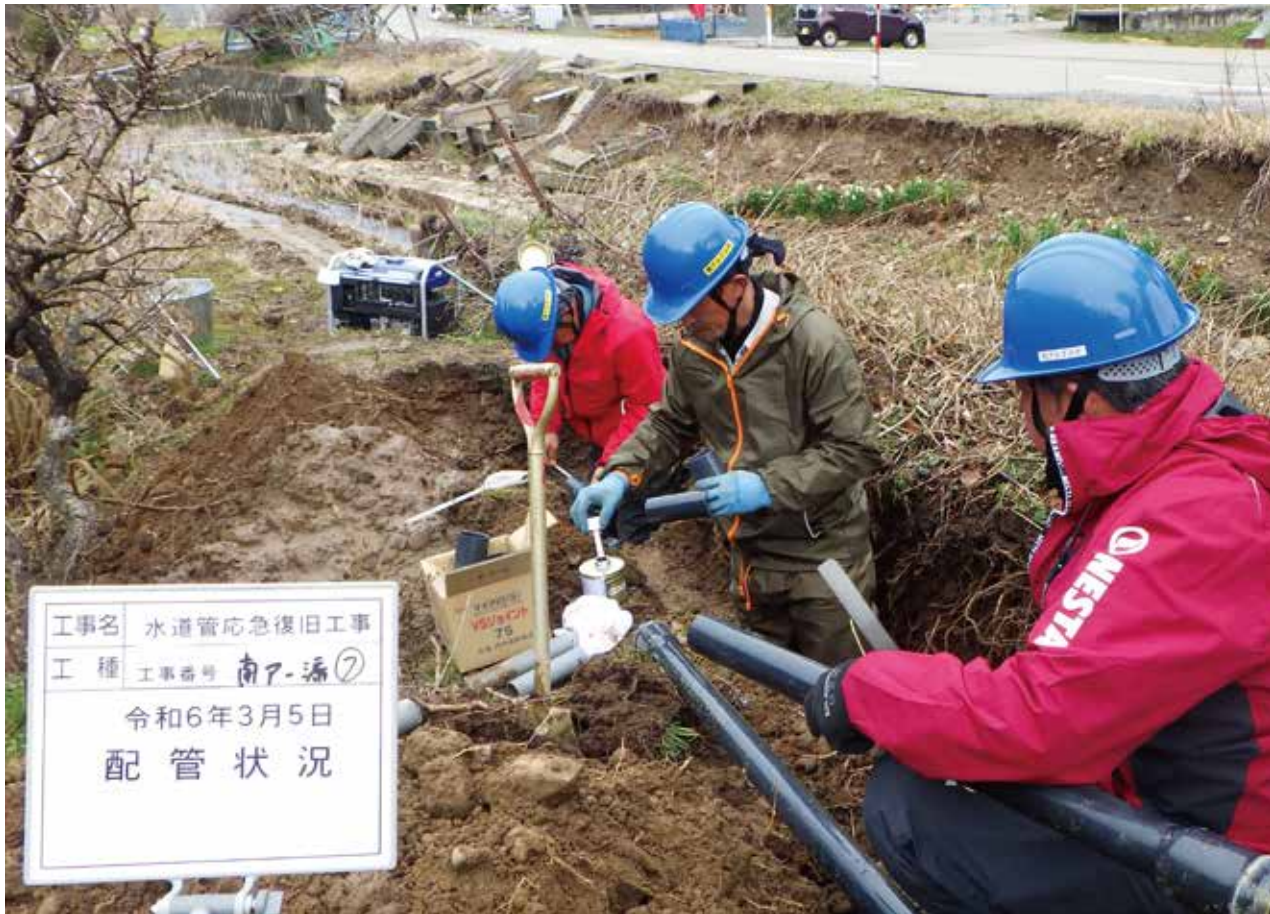
南アルプス市管工事協同組合員らが石川県輪島市で水道管応急復旧工事をする様子
