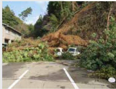
穴水町役場前の山が崩れ、公用車が巻き込まれる
