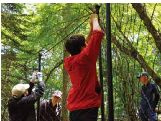
櫛形山での防護柵の設置
