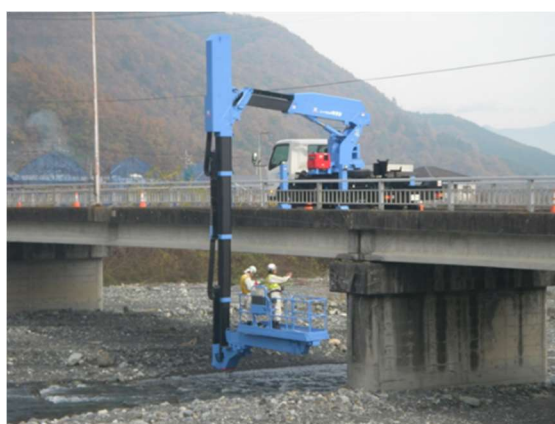
点検車による点検実施状況（白根西橋）
