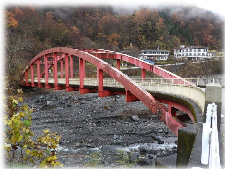
市道 小曾利日中線「瀬戸大橋」
