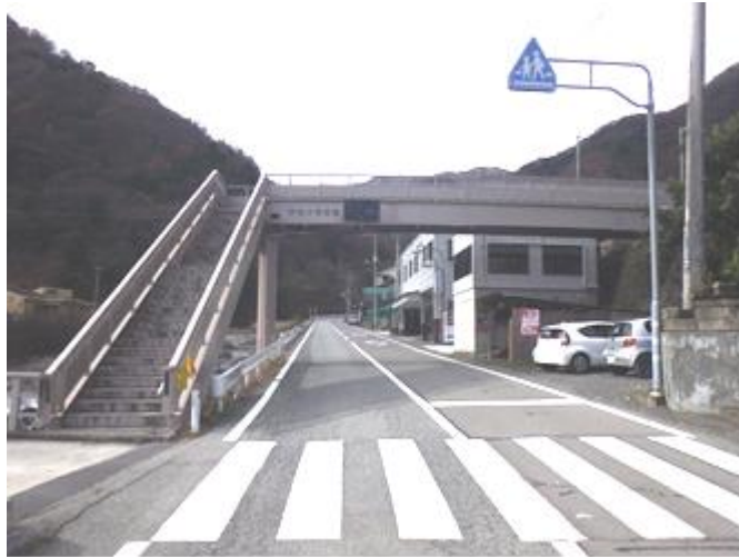
(中央橋横断歩道橋)
