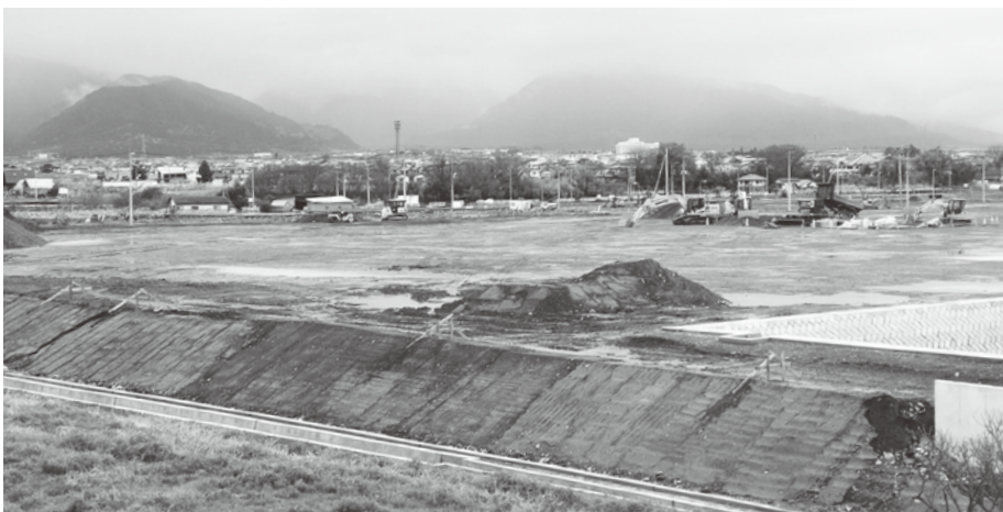
造成工事が行われている下今諏訪工業団地
