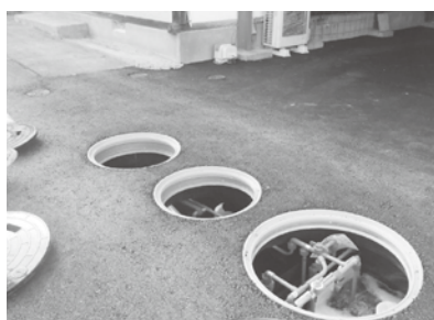
設置された合併浄化槽のようす
