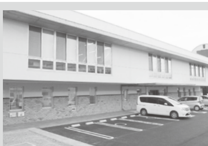
南アルプス市役所 新館
