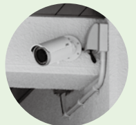
小中学校に防犯 カメラを設置 (写真は豊小学校)
