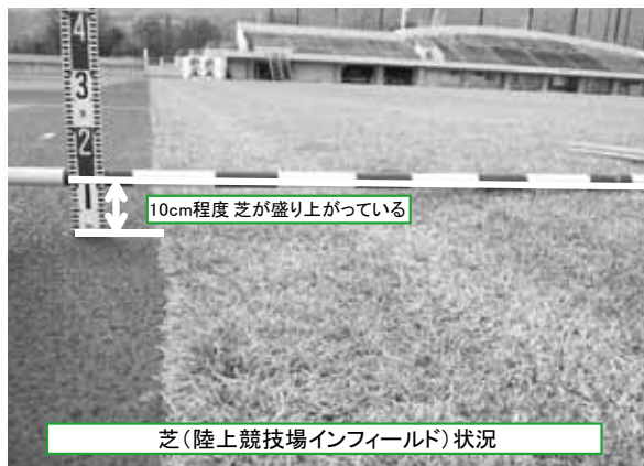
平成30年度に改修予定の櫛形総合公園陸上競技場
