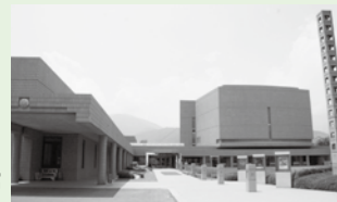
桃源文化会館 (現在は改修工事中)
