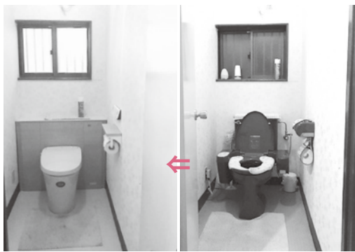
住宅リフォーム等総合支援事業を活用したトイレのリフォーム例 (右が改装前、左が改装後)
