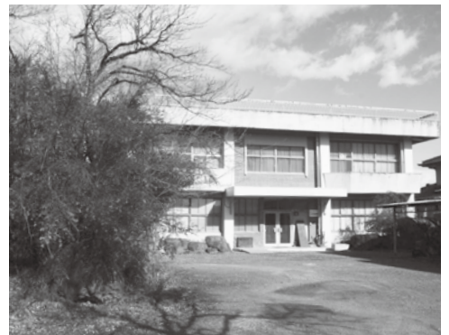
解体される甲西文化財調査事務所
