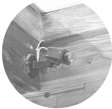
市内の公共施設に設置されている防犯カメラ
