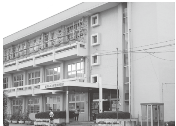
改修される本庁舎（西別館）
