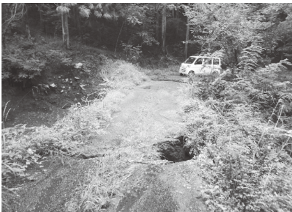
復旧工事が行なわれる林道大和川線
