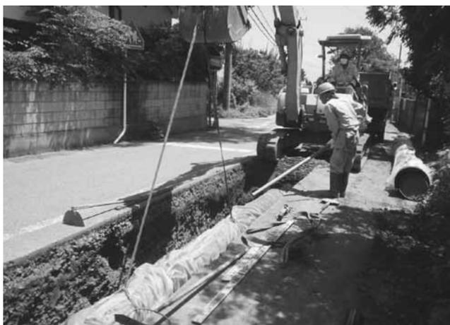
耐震管の布設工事の様子（西野地区）
