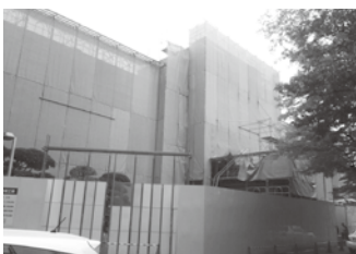
耐震補強を行う県庁別館
