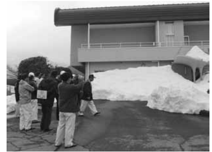
櫛形西小学校屋内運動場
