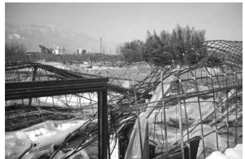
大雪により倒壊した農業用施設（八田地区内）
