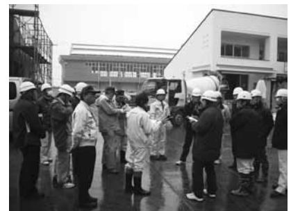
南湖保育所建設現場
