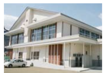
白根源小学校の屋内運動場
