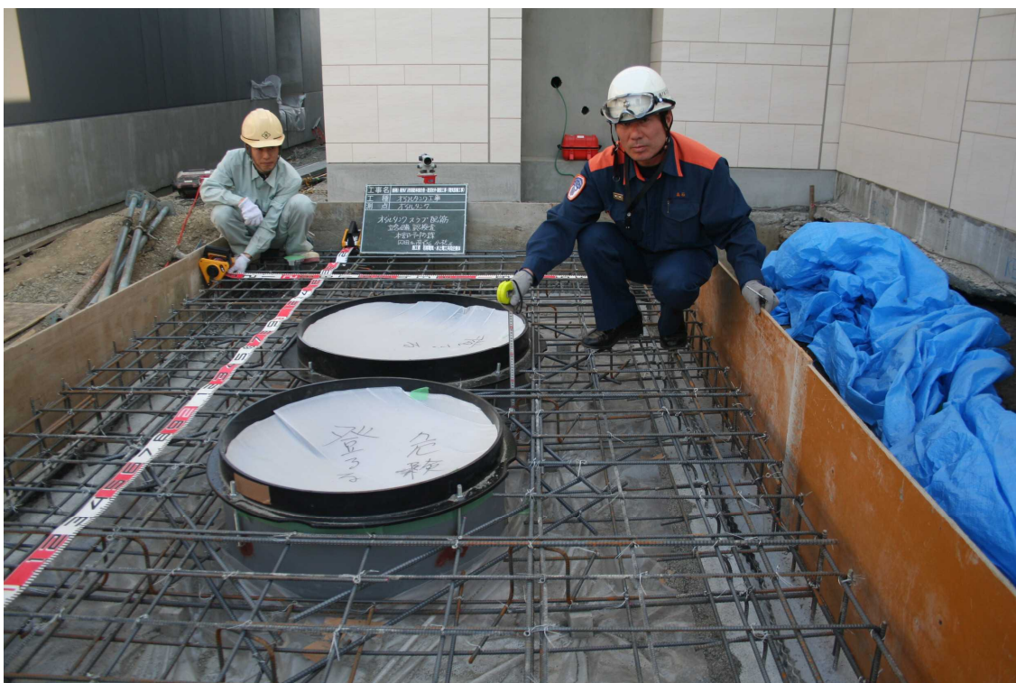
危険物施設検査
