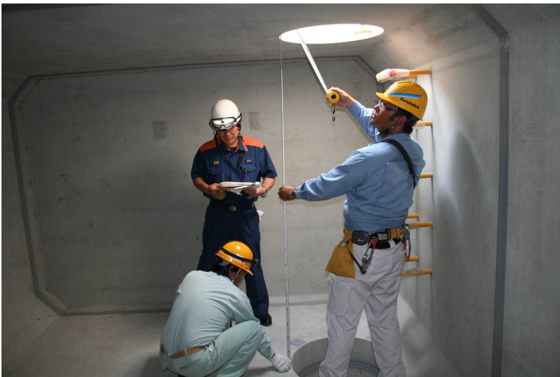
消防用水地下式水槽検査
